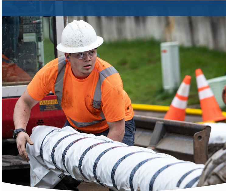
Reparación y reemplazo de infraestructura obsoleta
