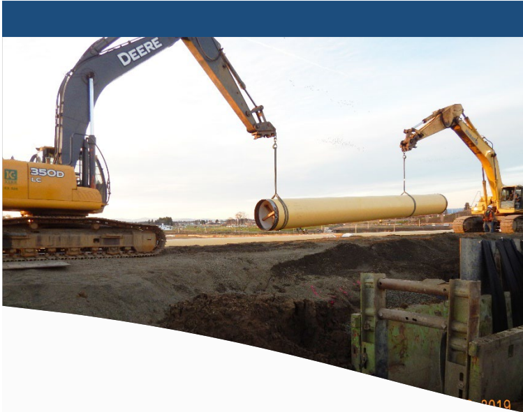
Construcción del suministro adicional de agua
